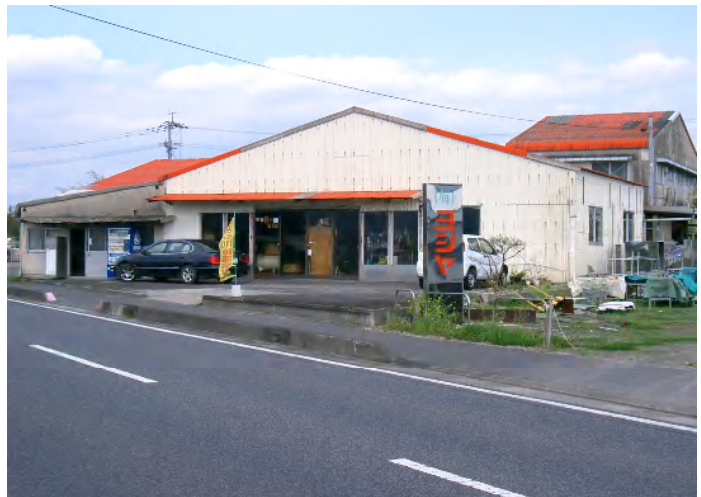
串良町有里工場
